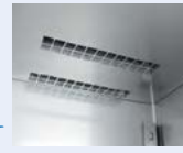
Détail ventilation intérieure
